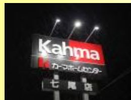
LED看板照明 LEDレクタングルライト 90度拡散タイプ 合計6台設置(両面)
