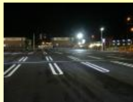
LED駐車場照明 LEDスクエアライト 直光タイプ 縦176m×横75mの駐車場 高さ7.5mの位置から
