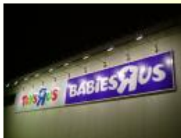
LED看板照明 (横12m×縦1.5m) LEDスクエアライト 90度拡散タイプ 9台設置
